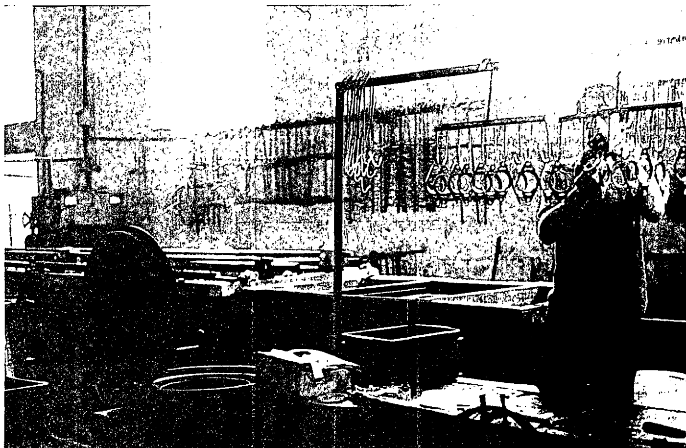
Fig. 1 - Impianto per il trattamento di decontaminazione, in bagno, di componenti di acciaio inossidabile (Eredi Guglielmo Macchi via Montegallio, 2 - Osson - MI).
