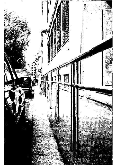
Fig. 7 - Transenne parapetonali, costituite da tubo saldato inox, nel centro di Milano. (Realizzazione: Bianchi G. e Figlio - Milano).
