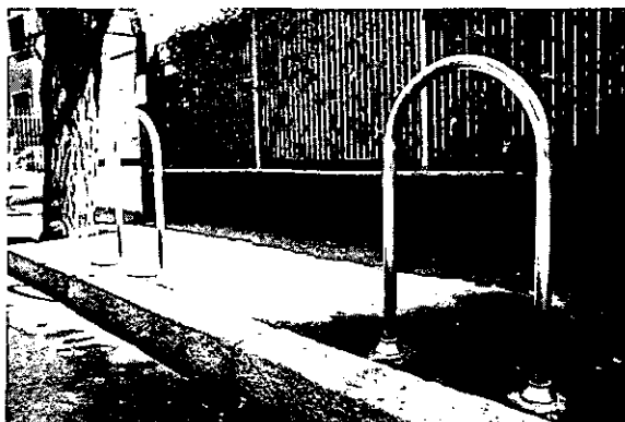
Fig. 12 - Elementi dissuasori inox, per evitare «parcheggi selvaggi» delle autovetture sui marciapiedi (Realizzazione: Officine Meccaniche Tornielli - Saronno - VA).
